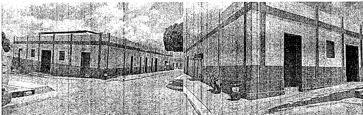
Figura 5 – Restauração da Infraestrutura do Mercado Público.
